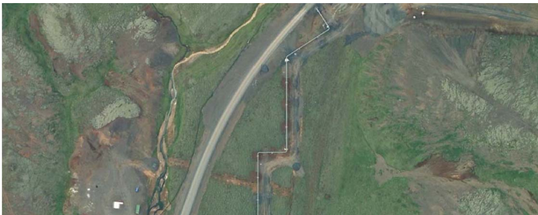
Mynd 12.7 Hefðbundnar lagnir ofanjarðar með Z-útfærslum séð úr lofti á framkvæmdatíma.
