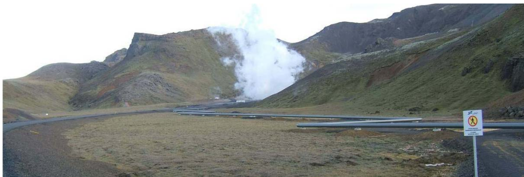
Mynd 12.6 Hefðbundin lögn ofanjarðar með Z-útfærslum
