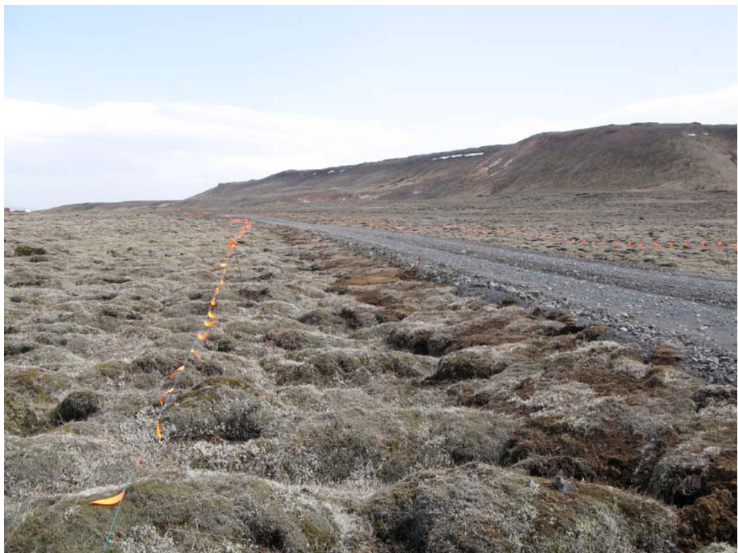
Mynd 12.13 Nýr vegur í Hverahlíð þar sem notast er við framangreint verklag.
